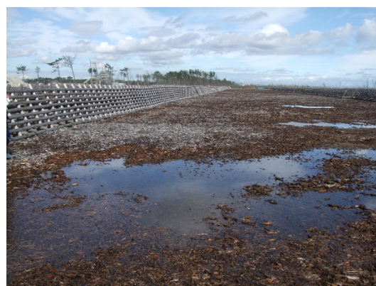
写真-4 植生基盤が完成し、クロマツ苗の植栽を待つ復旧現場。表面にはチップが散布されている。2013年10月。宮城県仙台市若林区。
