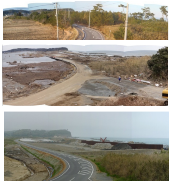
写真-1 海岸防災林(福島県南相馬市 釜舟戸地区)の状況(ケースA)。上、2011年1月;中、2011年3月;下、2013年5月。福島県相双農林事務所提供。
