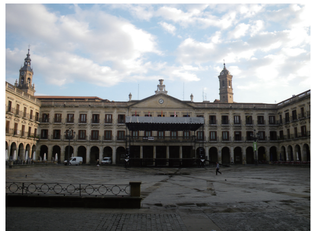
写真-2 スペイン広場にある町役所
